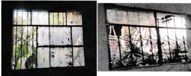
Foto1: Sustitución de vidrios
