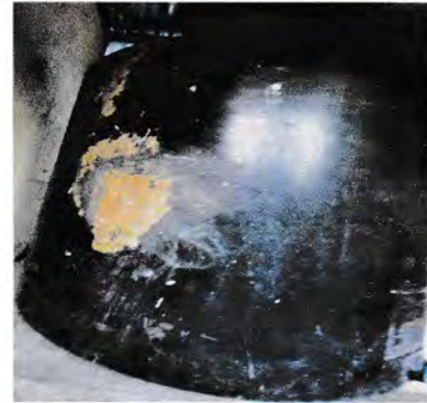
Foto 2: Sustitución de depósito de agua en mal estado, fotografía muestra reparación que se le realizó para poder mantener el agua en el tinaco
