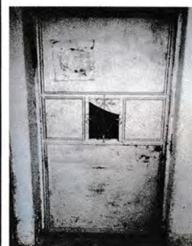
Foto 3: Sustitución de puerta
