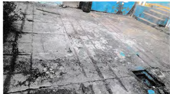
Foto 4: Reparación de piso concreto
