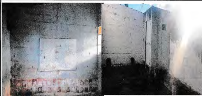
Foto 5: Pintura interior y exterior
